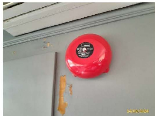
อุปกรณ์แจ้งเหตุเพลิงไหม้ด้วยเสียง
