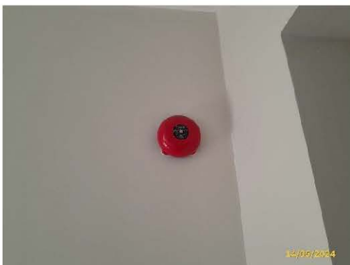
อุปกรณ์แจ้งเหตุเพลิงไหม้ด้วยเสียง
